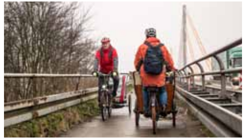
So eng sollte die neue Brücke der A 40 auch zukünftig für Radfahrende werden.
