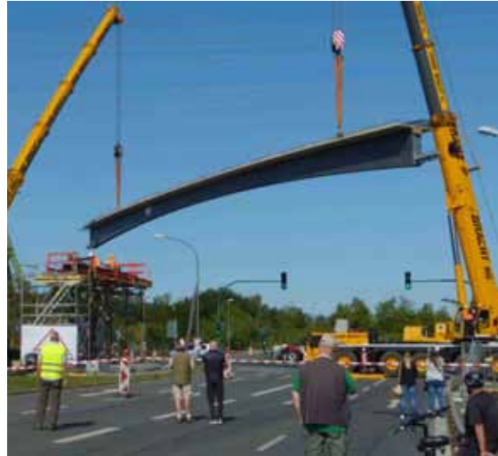
Das erste Element der RS1-Brücke über den Berthold-Beitz-Boulevard wird eingehoben
